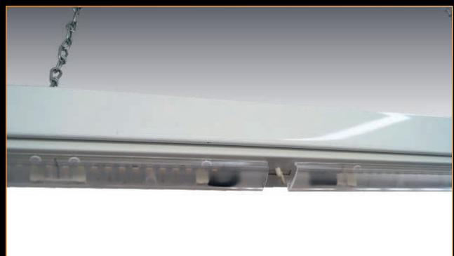
Durch den in der alten Trägerschiene vorhandenen Verschluss wird der Geräteträger fixiert. Die neue Leuchte ist sofort einsatzbereit. Geringe Beeinträchtigung des laufenden Betriebs.
