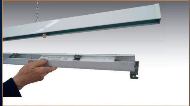
Der vorhandene Geräteträger mit der veralteten Technik wird aus der Trägerschiene entnommen. Diese bleibt erhalten und wird weiterverwendet.
